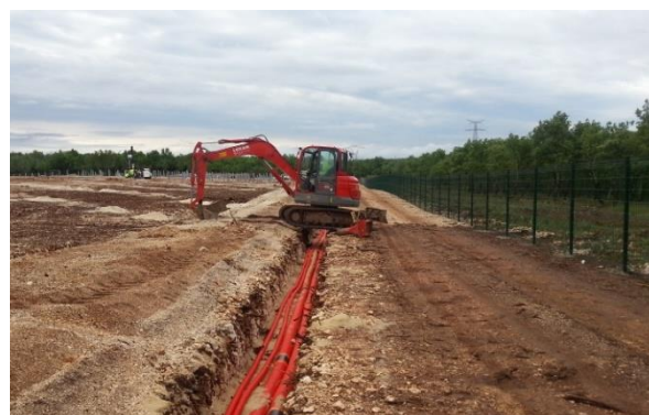
Exemple d'enfouissement de câbles électriques
