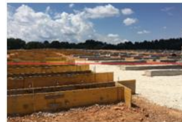
Illustration 12 : Exemples d'utilisation de longrines béton sur les chantiers URBASOLAR de La Chapelle Gonaguet (24) (source : Urba 312)
