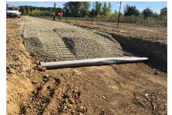
Exemple de réalisation de voie d'accès interne
