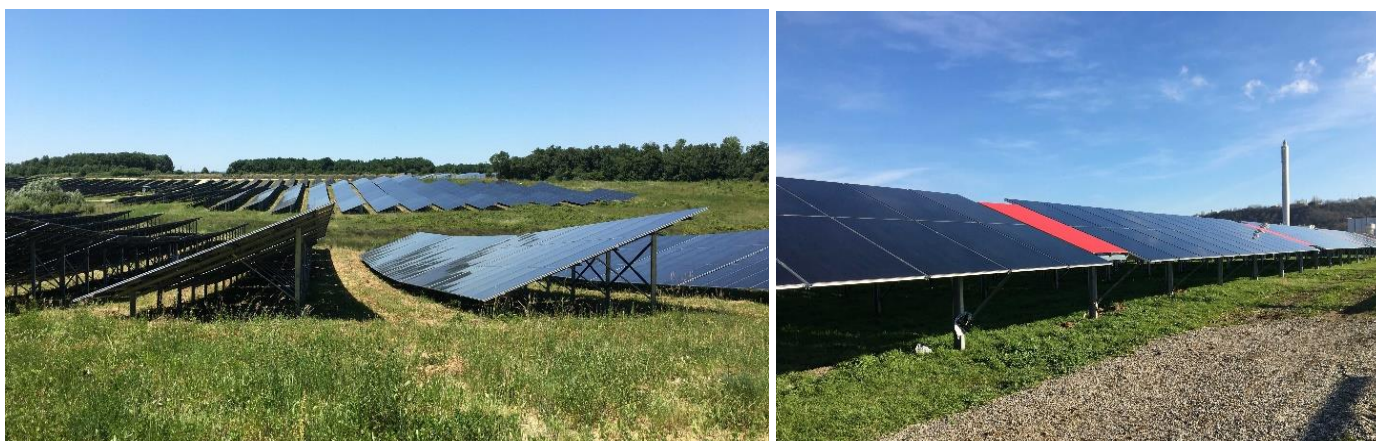
Illustration 5 : Exemples de réalisations Urbasolar : Nersac (16) et l'Oncopole de Toulouse (31) (source : Urbasolar)
